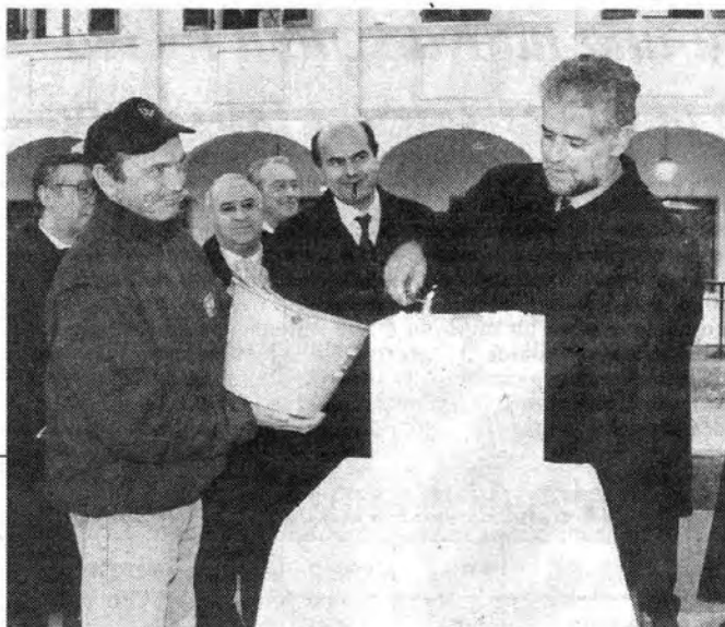
La posa della prima pietra dell'inceneritore di Parona. In secondo piano s'intravede Pier Luigi Filippi
